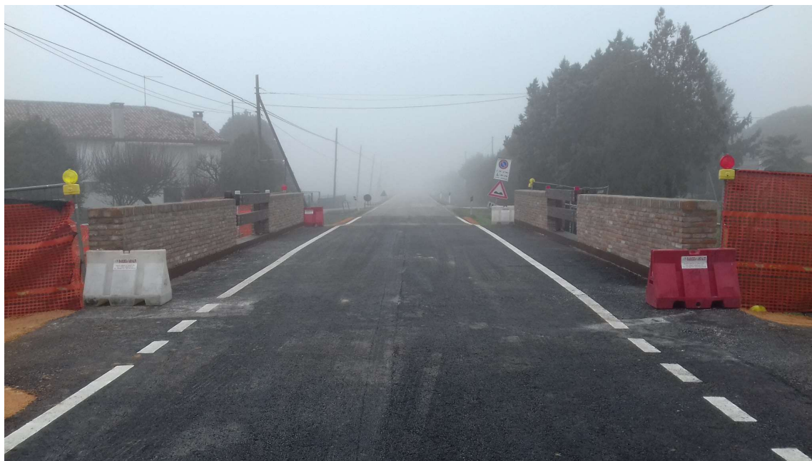
Ponte allargato SP35 Terrassa Padovana
